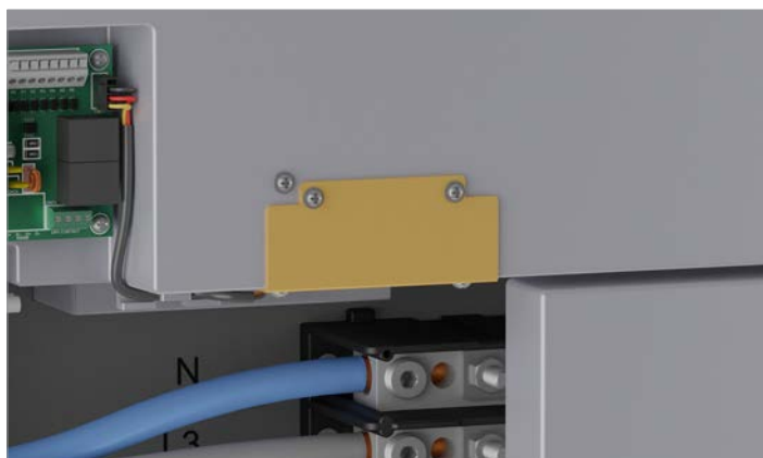
Position du ventilateur interne 1
